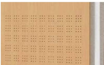
Ces cloisons sont composées de 2 panneaux perforés en médium (épaisseur 2 x 8 mm) avec âme centrale en mousse de mélamine (épaisseur 8 mm).
